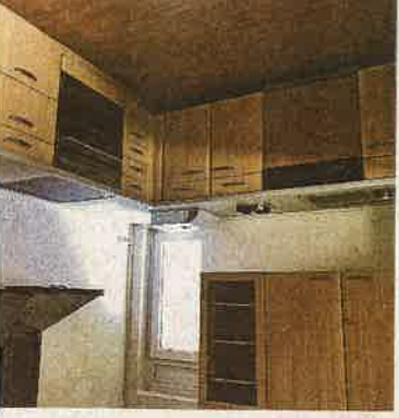
Auch die Küchenzeile soll komplett erneuert werden.
